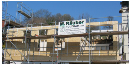
Tag 2 Das Aufrichten der Wände und verlegen der Brettstaneldecke
