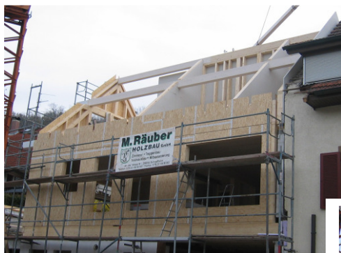
Tag 2 Das Aufrichten der Wände und verlegen der Brettstaneldecke
