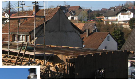
Tag 1 Der Abriss Die Scheune muss weichen
