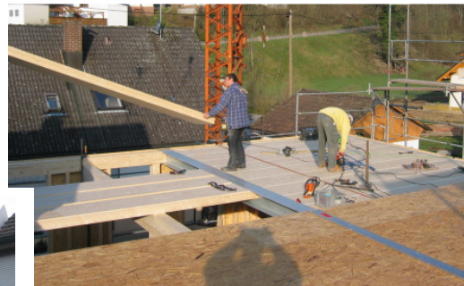
Tag 3 Verlegen der Dämmung
