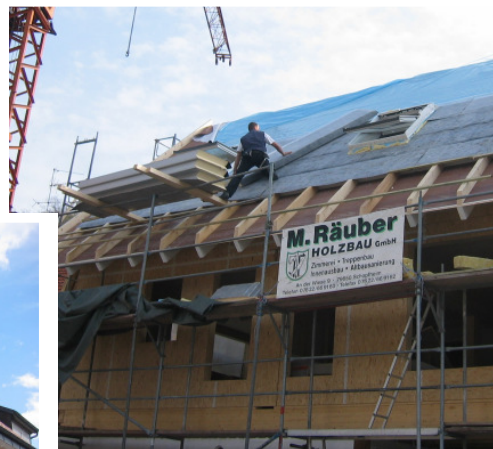
Tag 3 Verlegen der Dämmung
